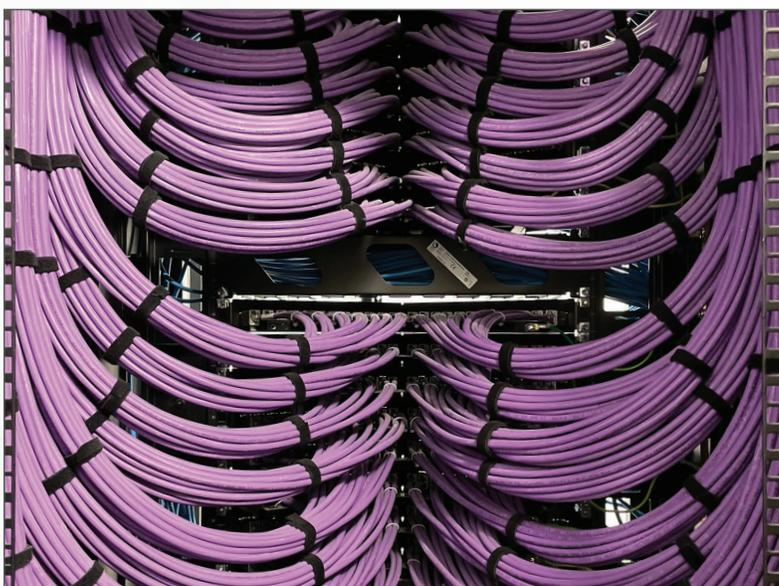
为了支持更高的带宽，用户选择了西蒙业界领先的Z-MAX®6A类屏蔽线缆及连接器，可支持高达每秒10G的数据传输速率，有助于提高性能并扩大覆盖范围。比之前的5e类系统有了显著升级，使科廷大学团队能够在整个图书馆内运用PoE供电来支持AV(音视频)、Wi-Fi(无线)、VoIP和安防等应用。整个解决方案由西蒙创新的PowerGUARD® (“保电卫士”)技术提供支持，以防止以太网供电负载下拔插插头产生的电弧侵蚀损坏连接点。
