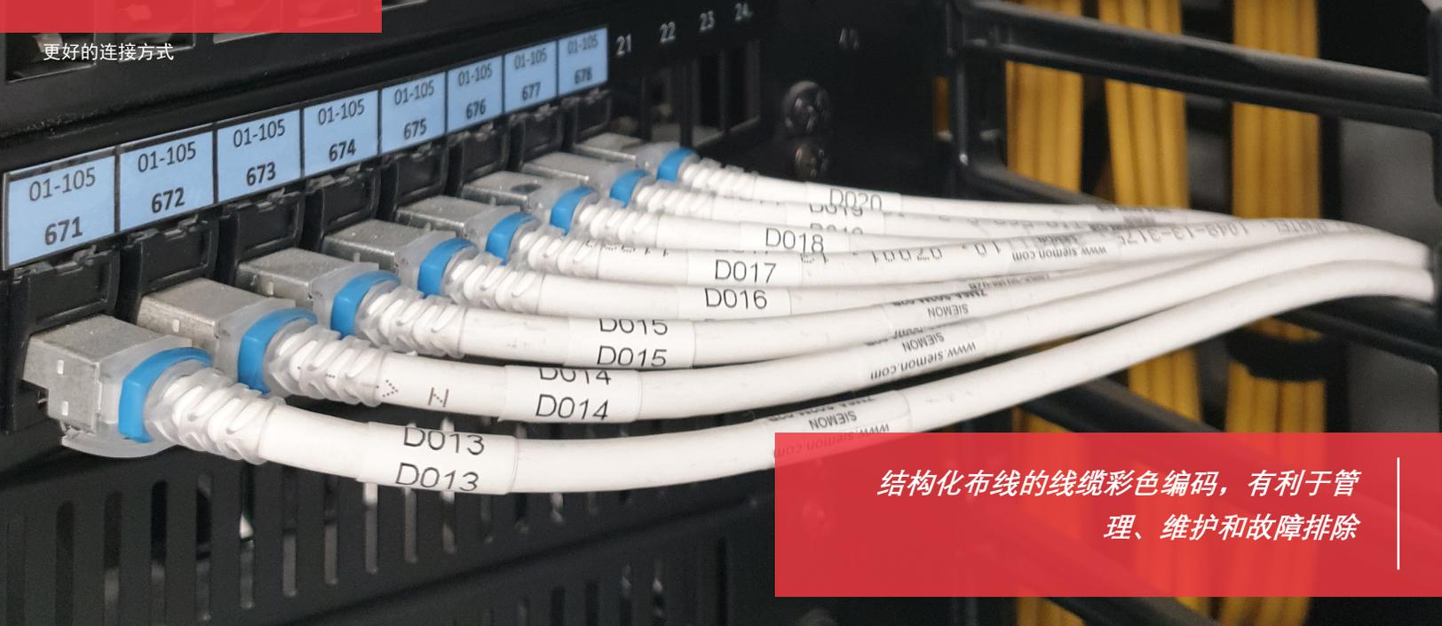
结构化布线的线缆彩色编码，有利于管理、维护和故障排除
