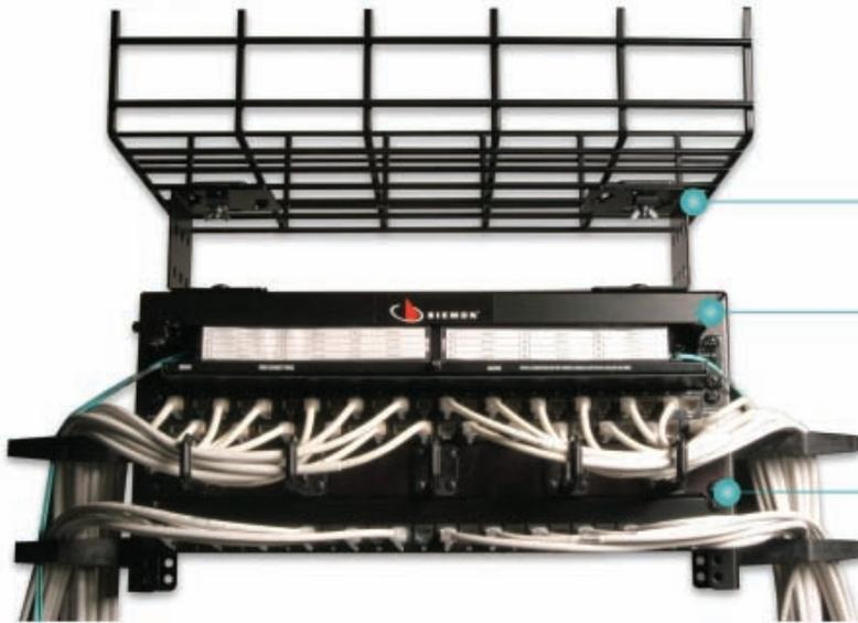
**改善散热效率** - 通过配线区域的管理和机柜机架上架线，可帮助改善空气流通，减少对设备冷却功能的阻碍
